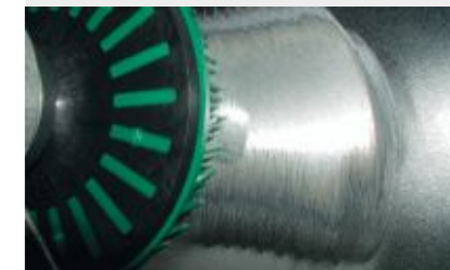
Usuwanie powłok malarskich
